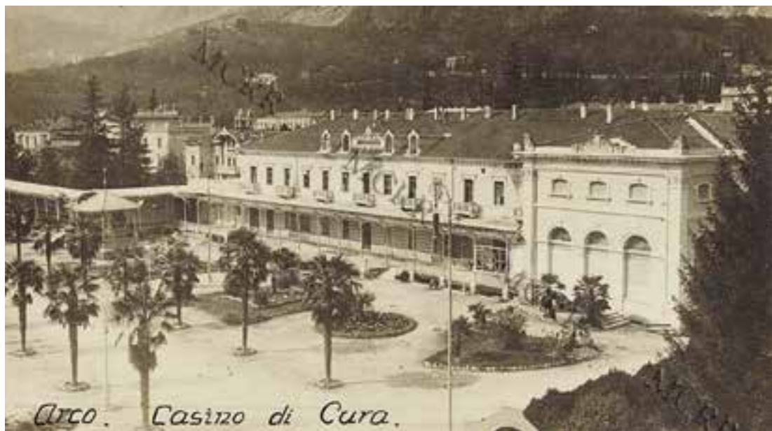
Fabbricati riattati per ricovero profughi. Arco Casinzo di cura.
