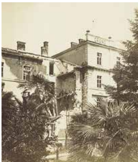
Fabbricati riattati per ricovero profughi. Arco Grande Albergo delle Palme (particolare). Resettled buildings to shelter refugees. Arco Grande Albergo delle Palme (detail). (Museo Centrale del Risorgimento)
